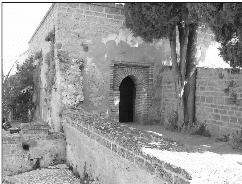
Baños árabes de Segura
